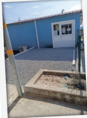
Liaison médiathèque/maison bleue afin de faciliter l'accès aux personnes à mobilité réduite à la maison bleue.
